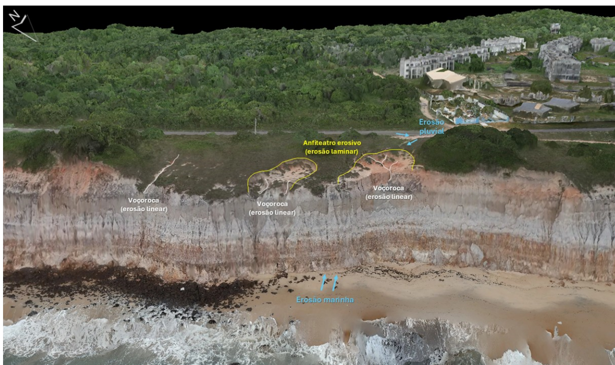
FIGURA 9: Erosão pluvial e marinha observado sobre a escarpa costeira.
