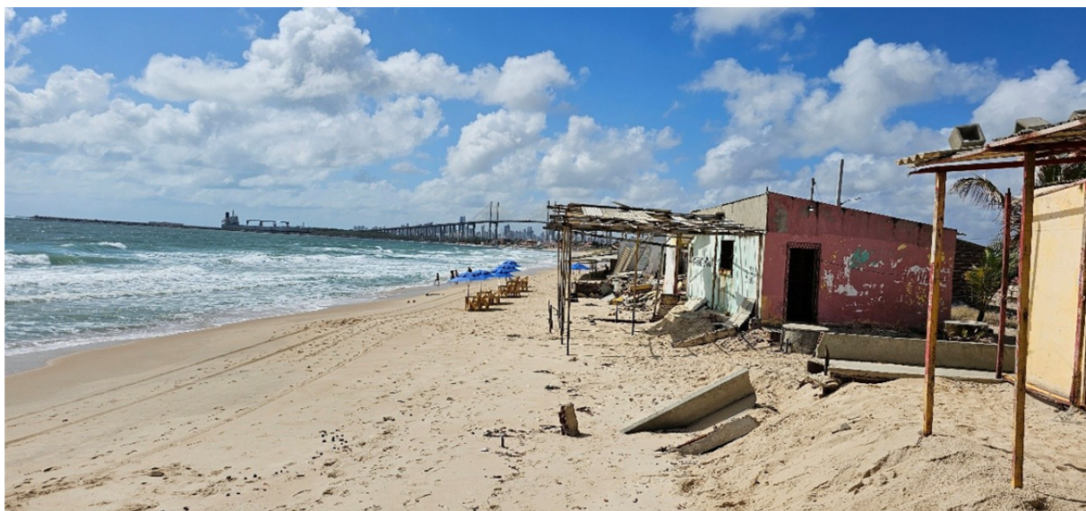
FIGURA 4: Degradação de bares e restaurantes na Praia da Redinha, 10 de outubro de 2024.
