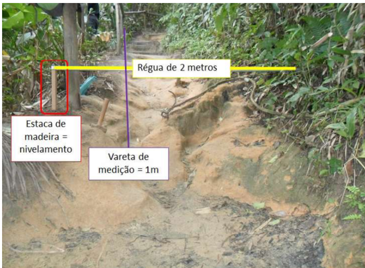
FIGURA 3 - Exemplo de nivelamento do PDE na geotrilha para a piscina natural Caixa D'Aço, no litoral do PNSB.
