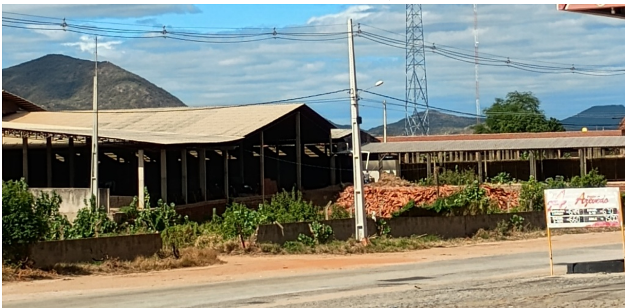
FIGURA 12 - Olarias situadas nas imediações do Geossítio.
