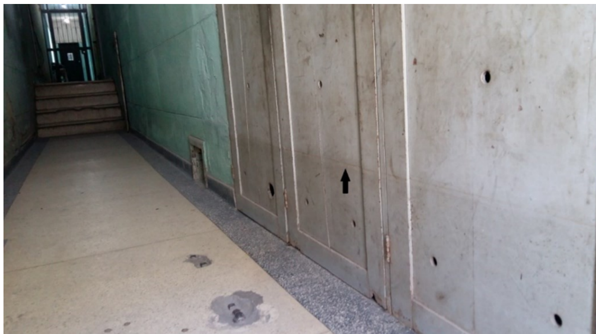
FIGURA 10- Portaria de um edifício na rua Laura de Araújo, com destaque para a linha que mostra a altura atingida pelas águas no alagamento mais recente e a elevação do acesso ao prédio.
