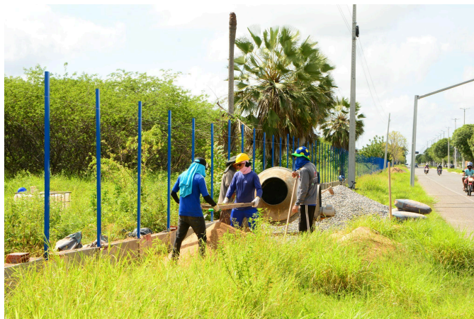
Construção de Muro Cercado - Campus Central FONTE- AGECOM
