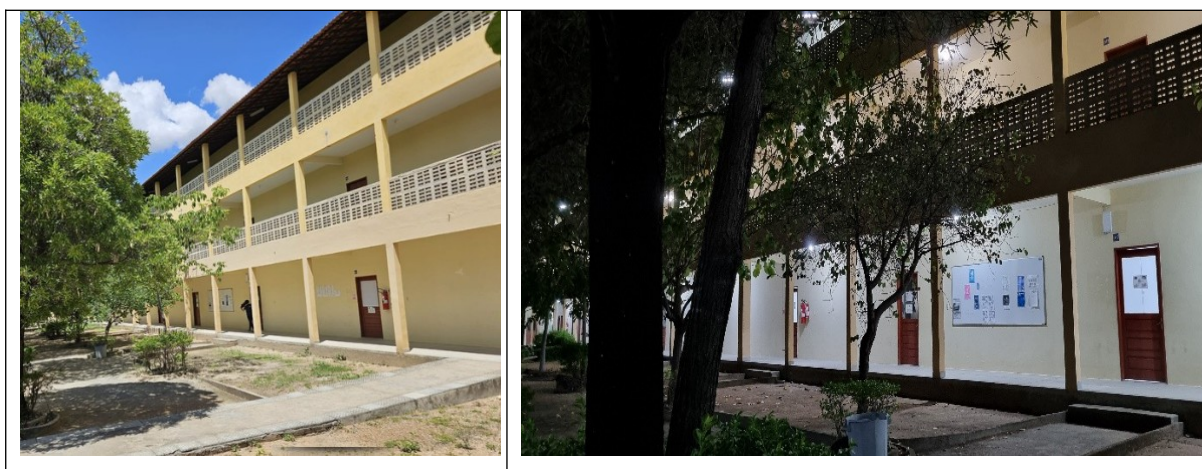
Fotografias 08,09 – BLOCO B, SALAS DE AULA
