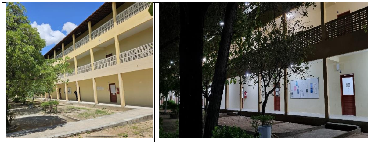
Fotografias 08,09 – BLOCO B, SALAS DE AULA
