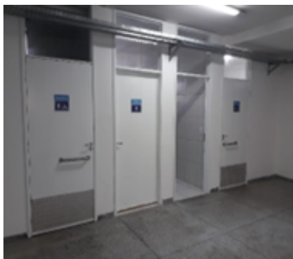
Imagem 40: Banheiros acessíveis no campus Natal.
