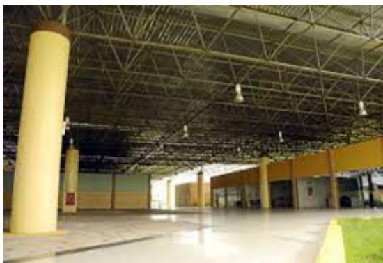
Imagem 37 Circulação e acessos internos no prédio sede do campus Natal
