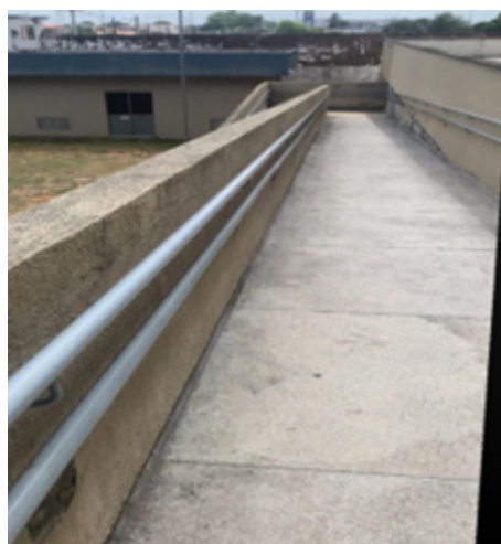
Imagem 35 Rampa externa para acesso principal ao prédio do campus Natal
