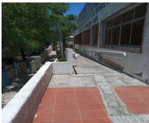
Imagem 14: Rampa de acesso à Faculdade de Enfermagem
