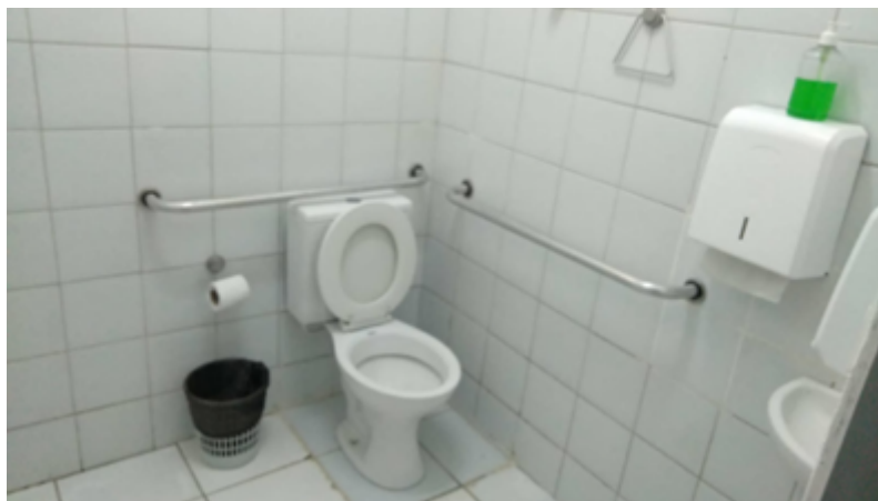
Imagem 25: Banheiro acessível no campus Patu
