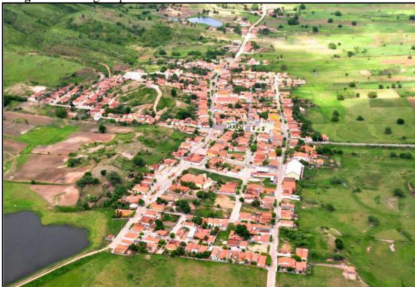
Figura 1 – Imagem panorâmica da zona urbana de Coronel João Pessoa-RN
