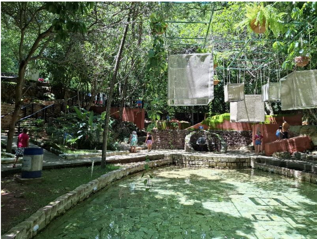
Figura 30: Nascente da Bica com intervenções construtivas
