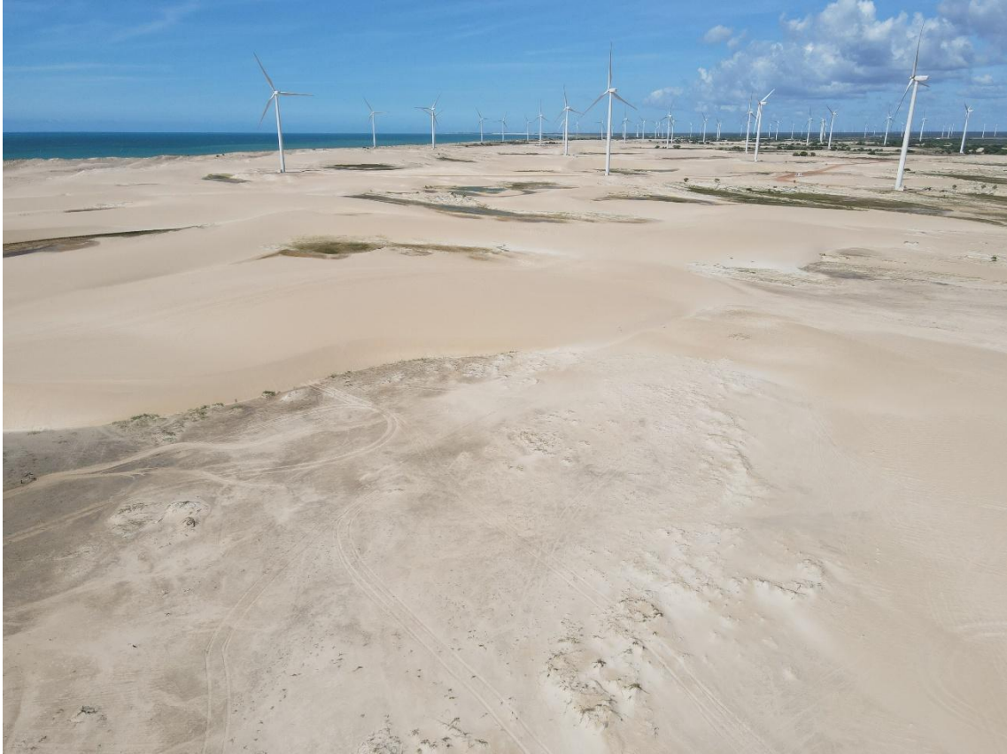
Figura 5.14 – Parque eólico no entorno do Geossítio
