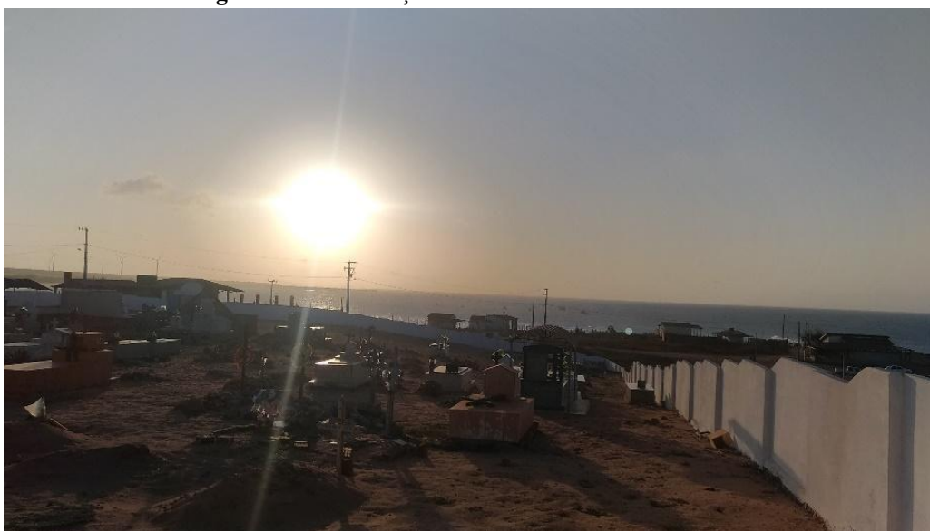
Figura 3.12 – Edificações no tabuleiro em São Cristóvão.
