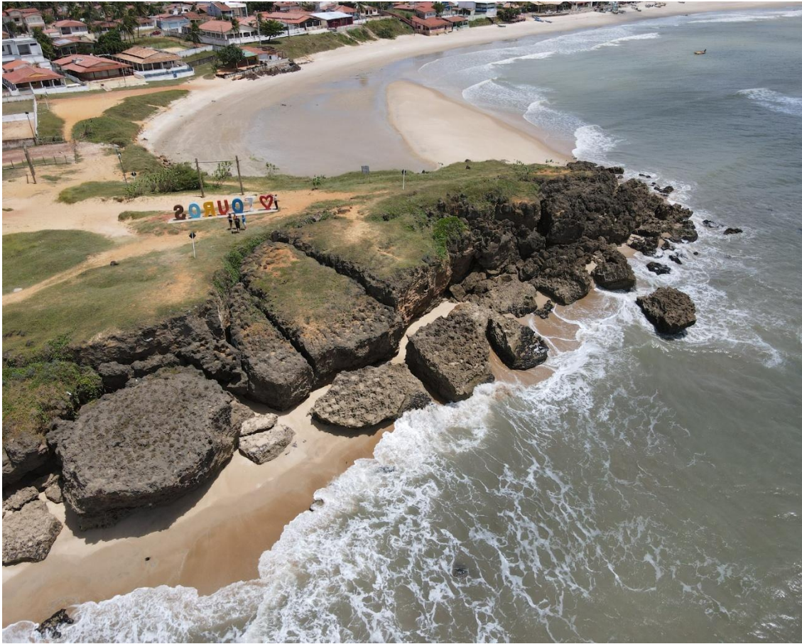
Figura 7.8 - Vista aérea da Falésia Tourinhos
