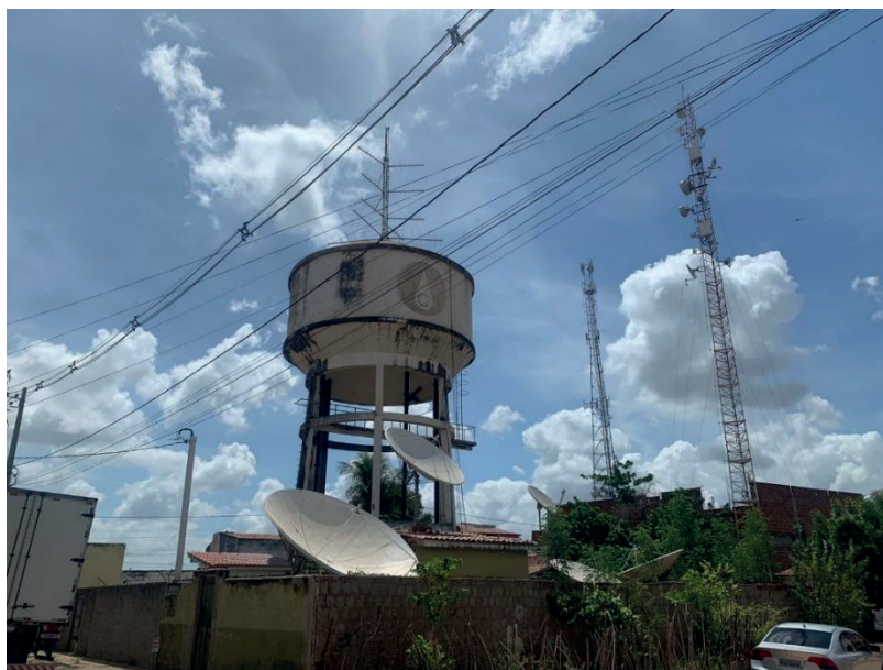
Figura 11: Reservatório elevado para abastecimento urbano de Apodi/ RN.
