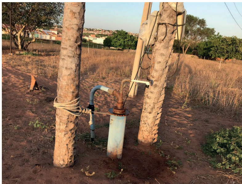
Figura 7 - Poço 6 (poço sem proteção)
