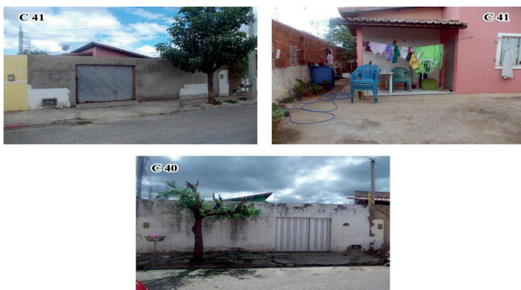
FIGURA 20 - IMÓVEIS C40 E C41, ALTO DO SUMARÉ, MOSSORÓ – 2023
