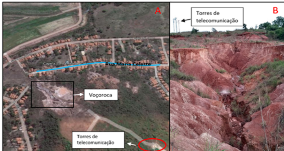
FIGURA 4: Voçoroca em relação às torres de telecomunicação. A: Localização da voçoroca. B: Vista das torres de telecomunicação a partir da voçoroca em estudo.
