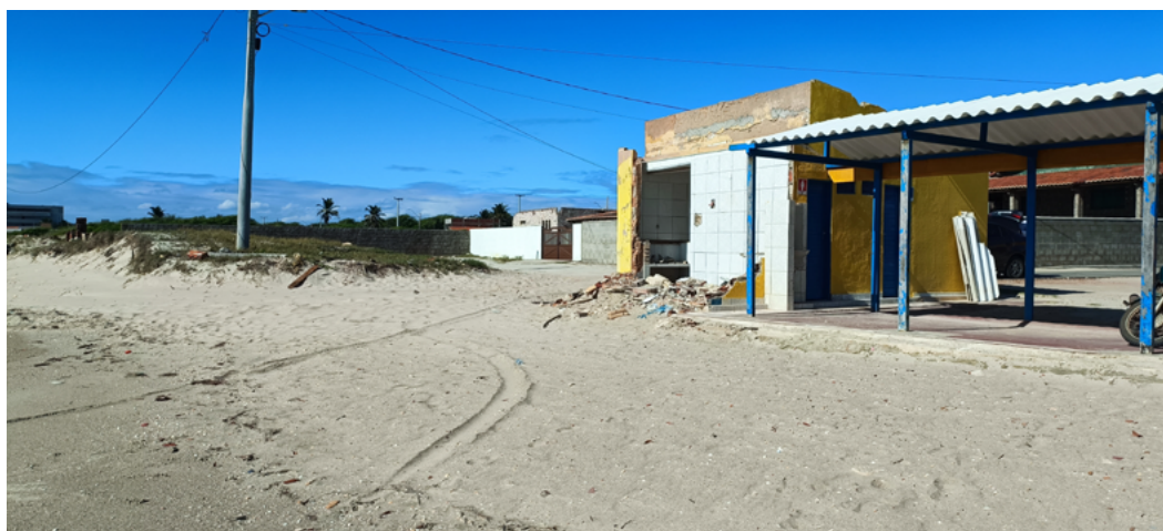
Figura 4. Parte da estrutura de uma barraca de praia destruída pela erosão costeira, Praia de Gado Bravo, Tibau.
