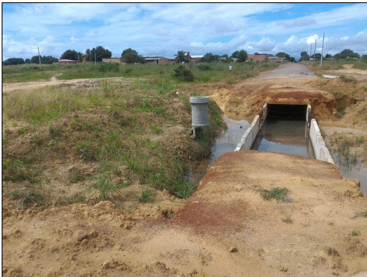
Figura 11 - Estrutura de uma galeria hídrica conectada ao corpo hídrico principal da BHC, Equatorial próximo a área de nascentes.
