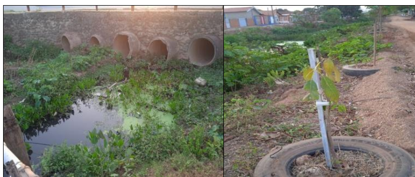
Figura 3- Manilhamento e revegetação no córrego Sangradouro
