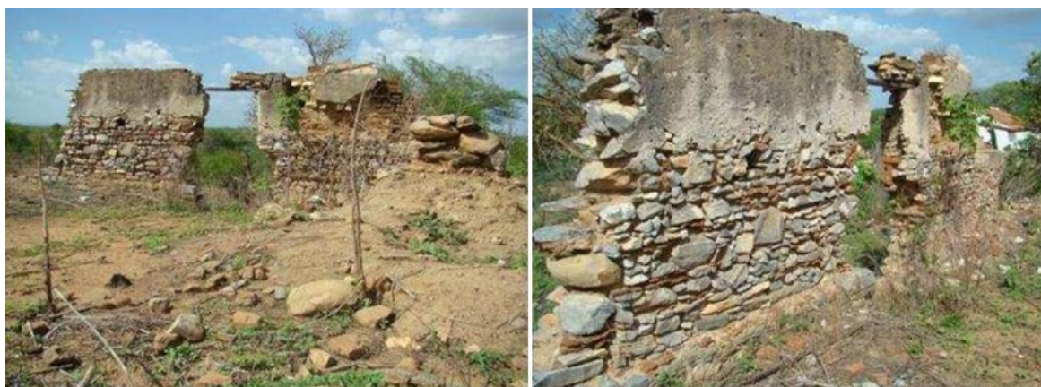
Figura 12 – Estrutura da primeira casa sede da Umary
