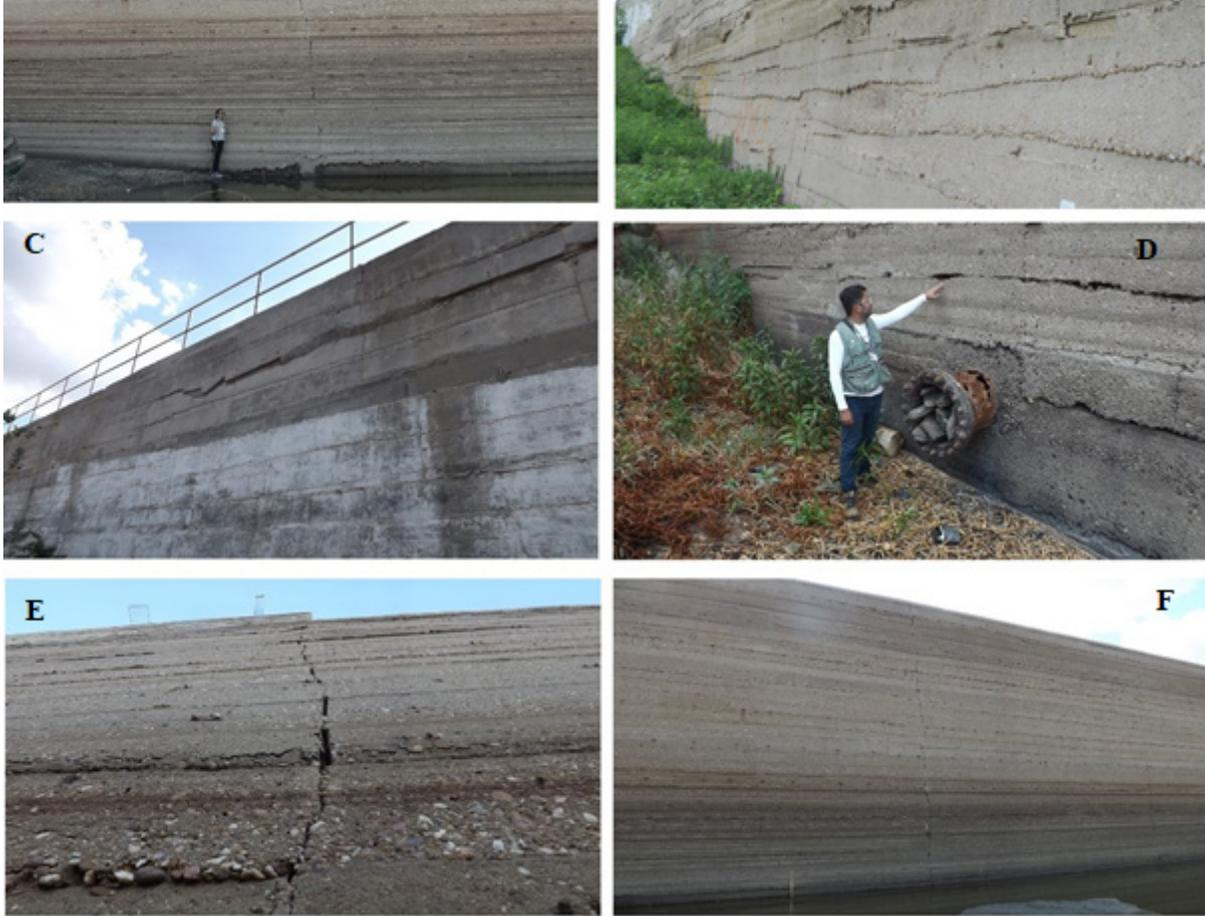
Figura 21 - Anomalias estruturais no paramento de montante 2
