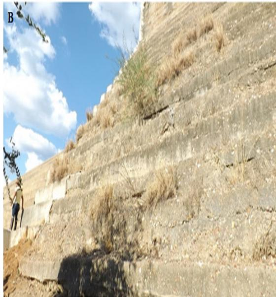
Figura 22 - Patologias estruturais no paramento de jusante
