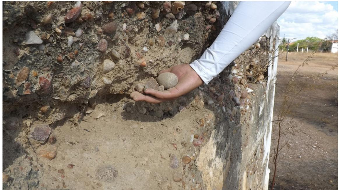
Figura 16 - Friabilidade no concreto compactado a rolo da ombreira esquerda
