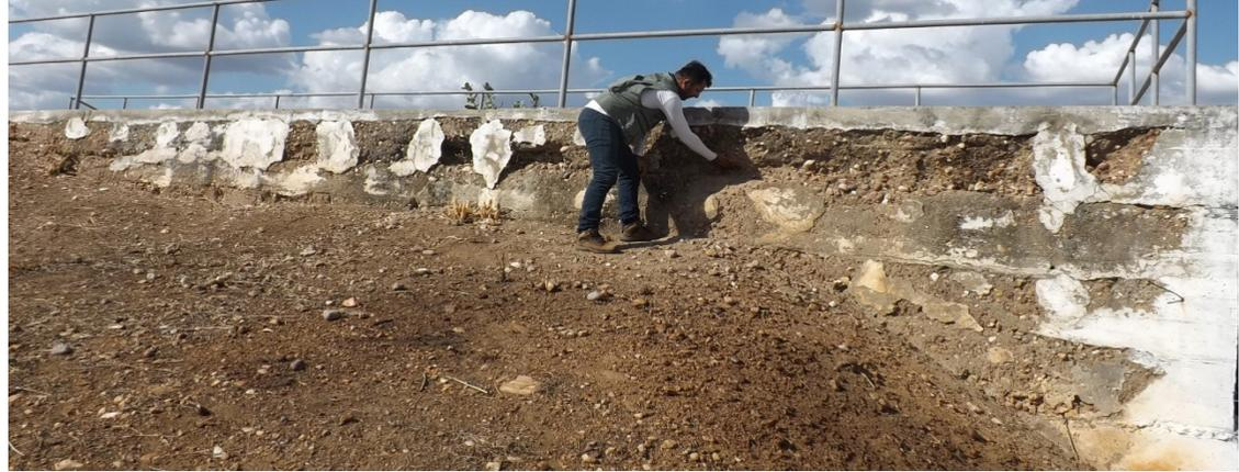
Figura 15 - Ombreira esquerda com processo de desagregação de concreto
