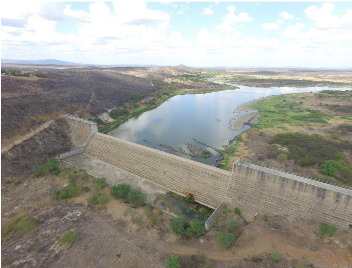
Figura 25 - Foto panorâmica do vertedouro e bacia de dissipação
