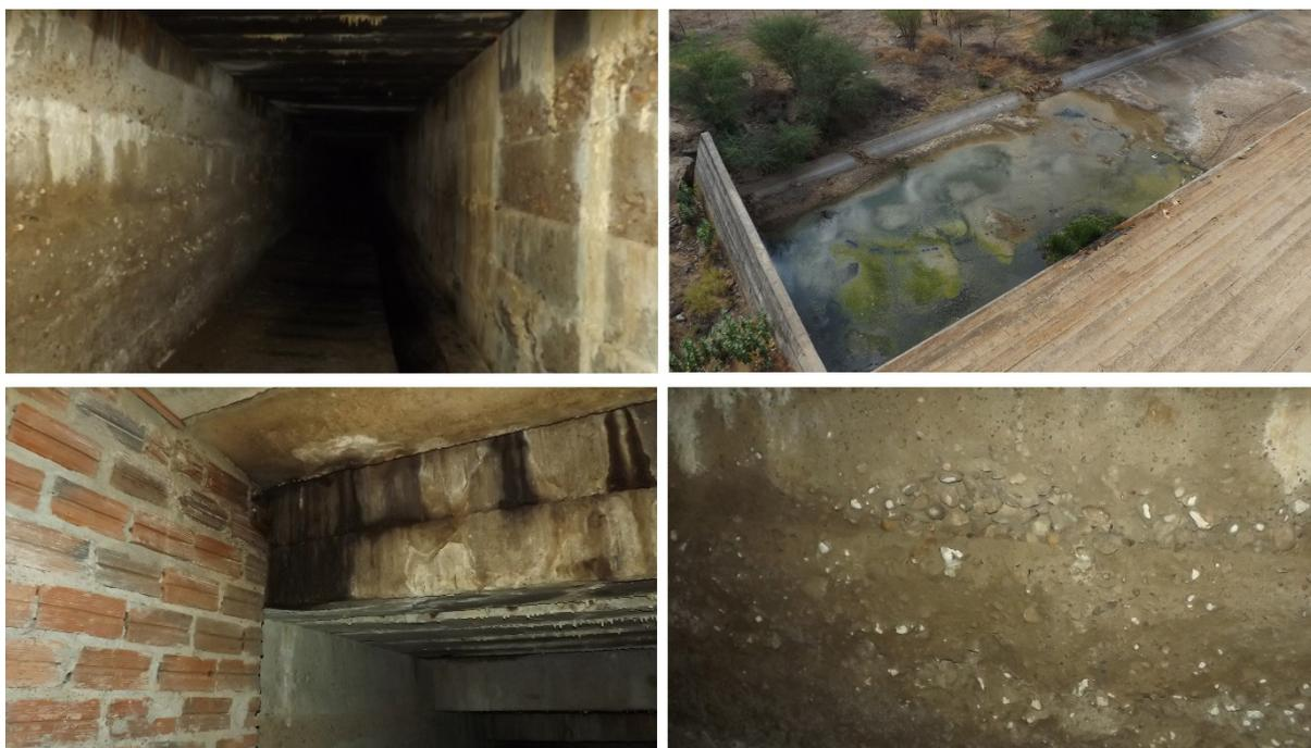
Figura 26 - Percolação e fuga de água na galeria e bacia de dissipação
