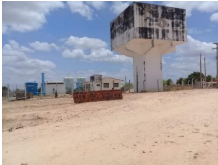
Figura 59: Unidade de Tratamento Hídrico da CAERN. Fonte: Acervo dos autores, 2019.
