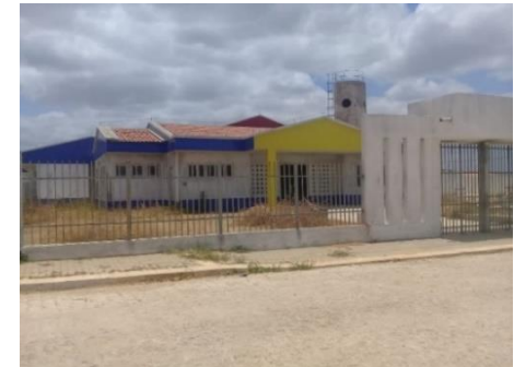
Figura 62: Creche Municipal. Fonte: Acervo dos autores, 2019.
