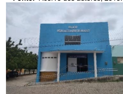
Figura 31: Câmara Municipal. Fonte: Acervo dos autores, 2019.
