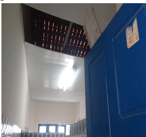
Figura A - Teto do banheiro feminino
