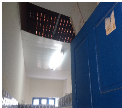
Figura A. Teto do banheiro feminino
