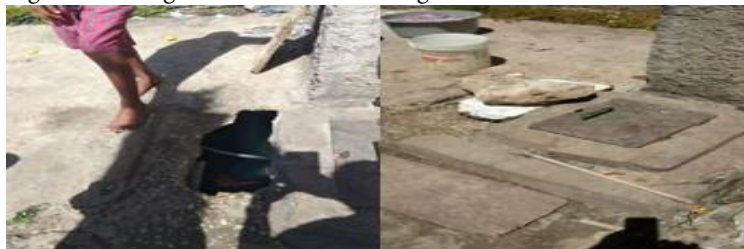
Figura 06: Imagens da cisterna do abrigo.
