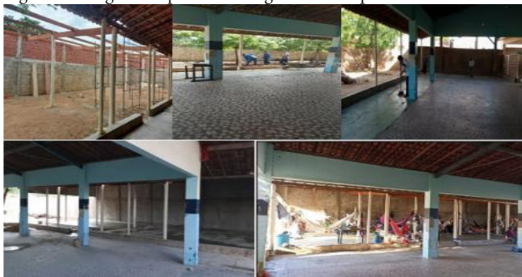
Figura 5: Imagens do pátio do abrigo sendo ampliado.
