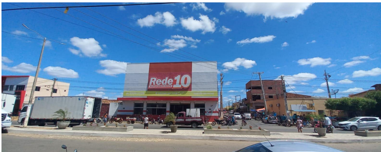
Figura 5: Unidade do Supermercado Rede 10 na cidade de Baraúna/RN.
