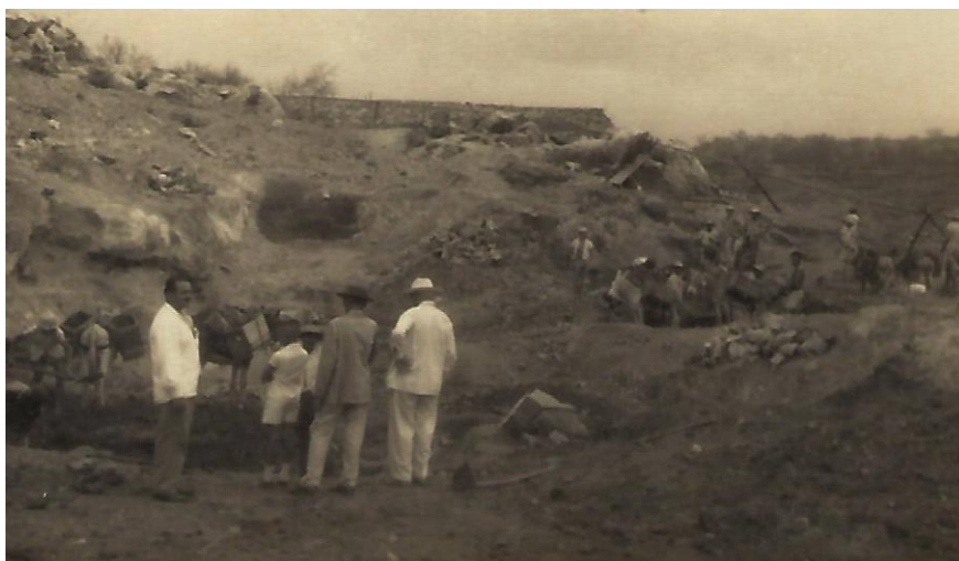
Figura 02: Paisagem visual do açude em construção, datada de 08 de outubro de 1962.
