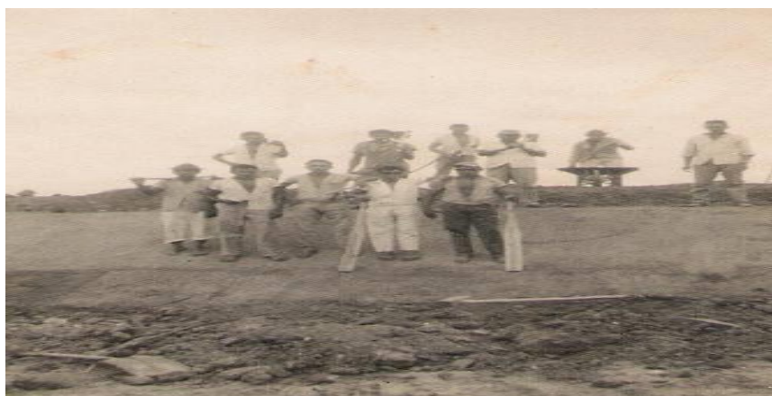
Figura 01: Trabalhadores na construção do açude. (Data a ser definida)
