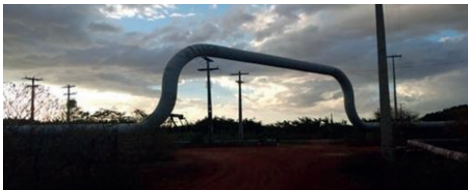
Figura 12: Dutos responsáveis pelo transporte de vapor
