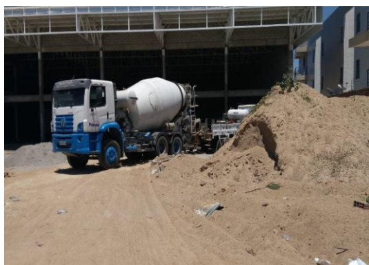
a) Caminhão betoneira de concreto
