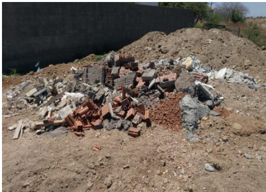
a) Armazenamento inadequado de resíduos sólidos
