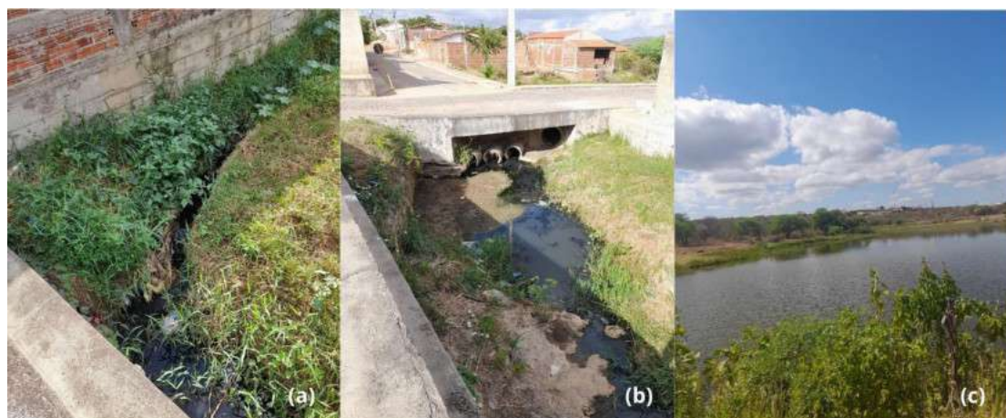
Figura 6 – Lançamento e escoamento de efluentes a céu aberto
