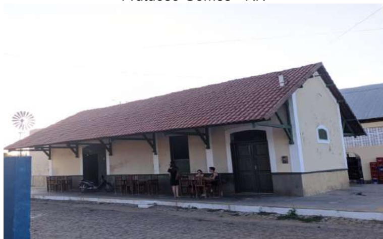
Figura 03 – Estação Ferroviária Mossoró-Sousa em seu estado atual no município de Frutuoso Gomes - RN
