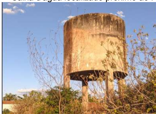
Figura 07 – Caixa d'água localizado próximo ao Rio Mineiro
