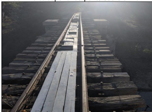
Figura 06 – Parte superior da ponte sobre o Rio Mineiro
