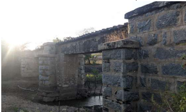
Figura 05 – Ponte ferroviária sobre o Rio Mineiro, Frutuoso Gomes - RN
