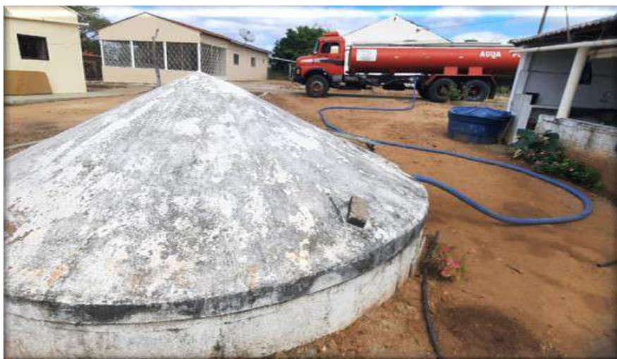
Figura 2 – Cisterna de placas para armazenamento de água
