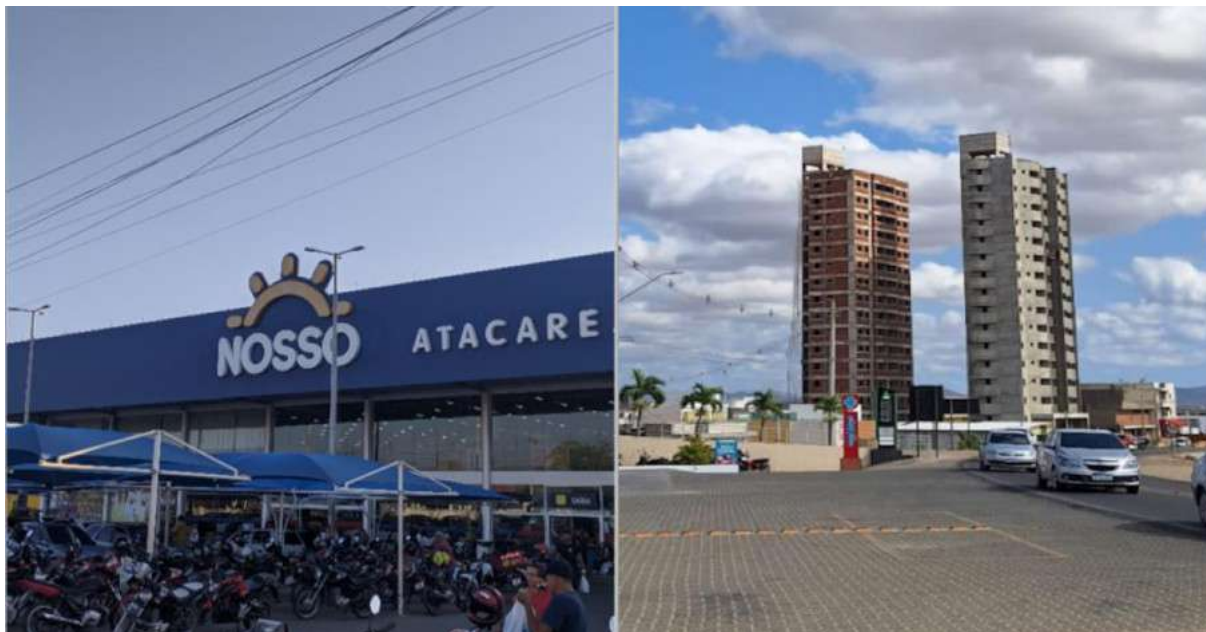
Figura 03 – Supermercado NOSSO Atacarejo e residencial Fontes Rêgo (em construção)
