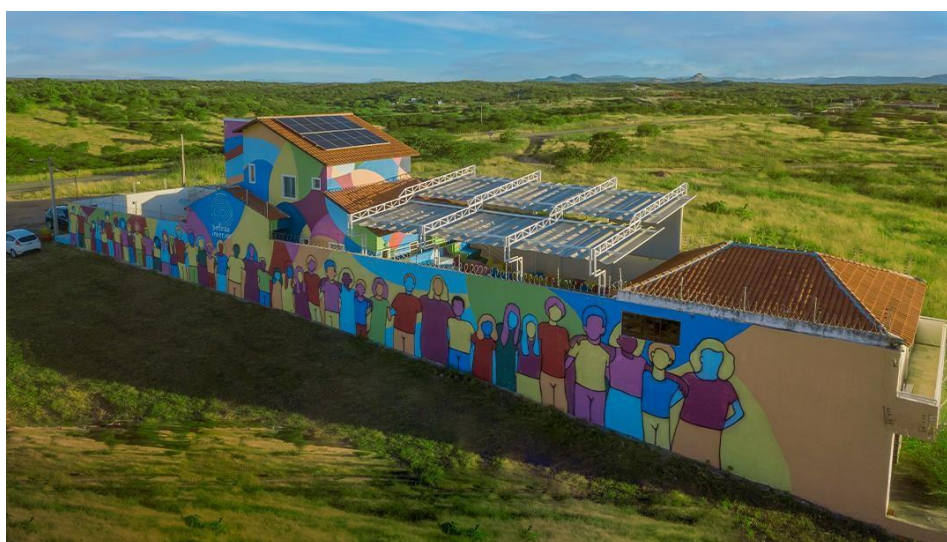
Foto 1: Vista do alto sobre o Instituto Beleza Interior, Alto Santo/CE. Fonte: Instituto Beleza Interior.
