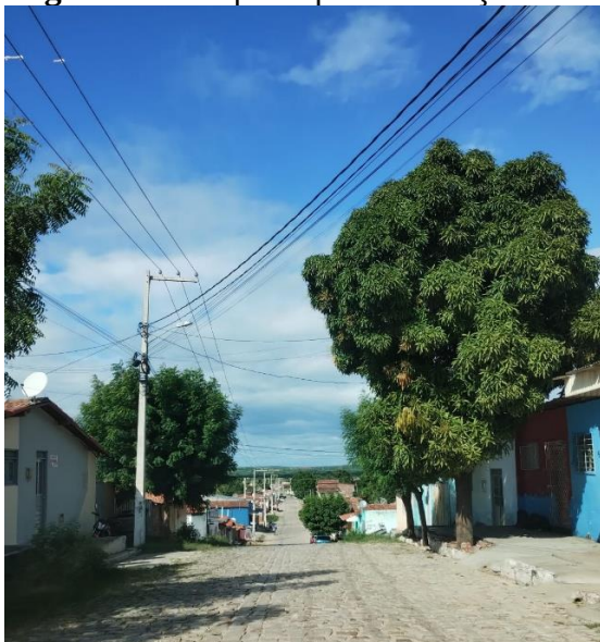
Figura 1 - Rua principal com calçamento.
