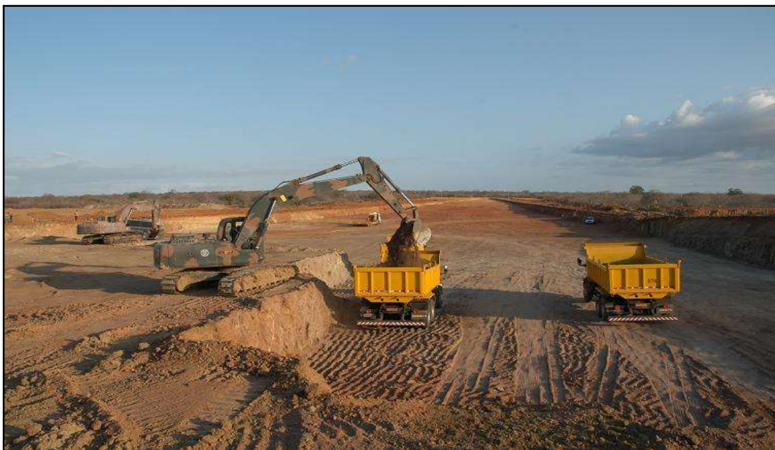
Foto 2: Obras da transposição no território da comunidade Santana.
