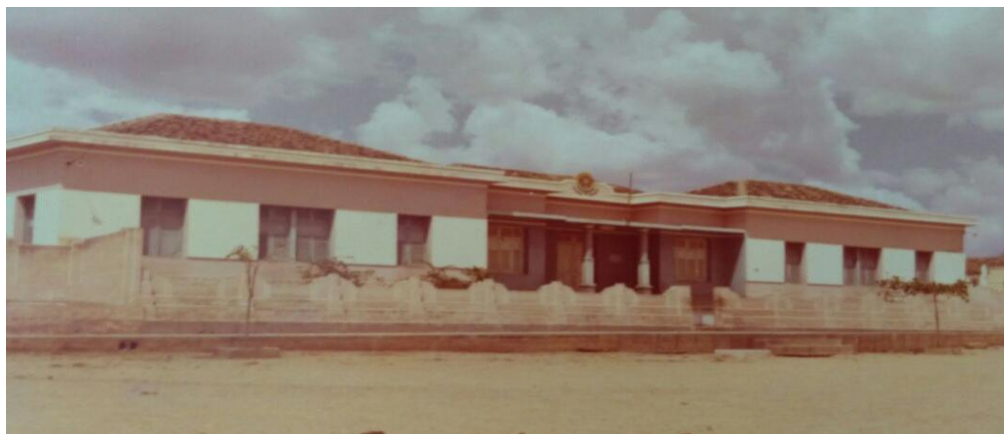
Figura 3 – Fachada do Grupo Escolar Antônio Carlos.
