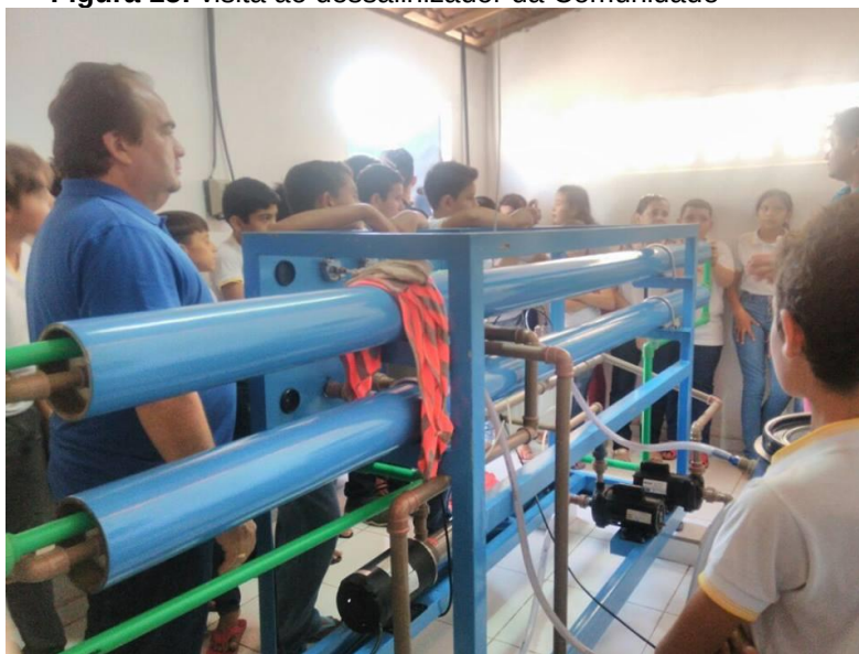
Figura 15: visita ao dessalinizador da Comunidade
