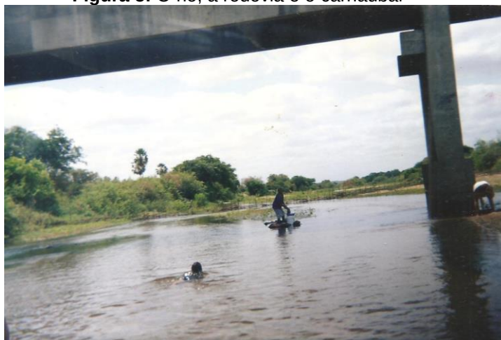
Figura 5: O rio, a rodovia e o carnaubal
