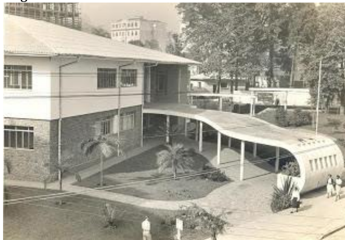
Figura 11: Fachada da Biblioteca Monteiro Lobato em 1950
