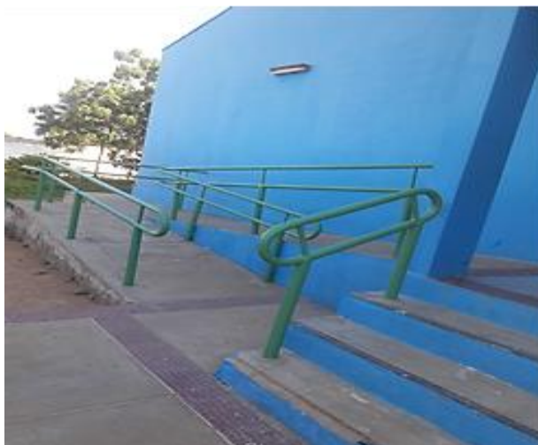
Figura 04 – Acesso lateral ao portão principal da escola
