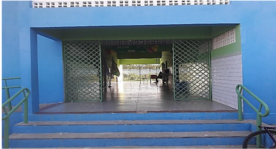
Figura 02 – Acesso principal da escola
